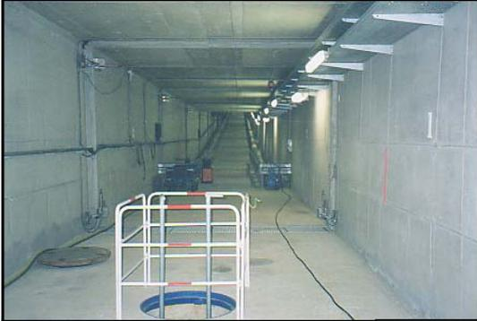
**Vista del túnel para control de lixiviados debajo de las celdas de confinamiento Blankheim, Al.**
